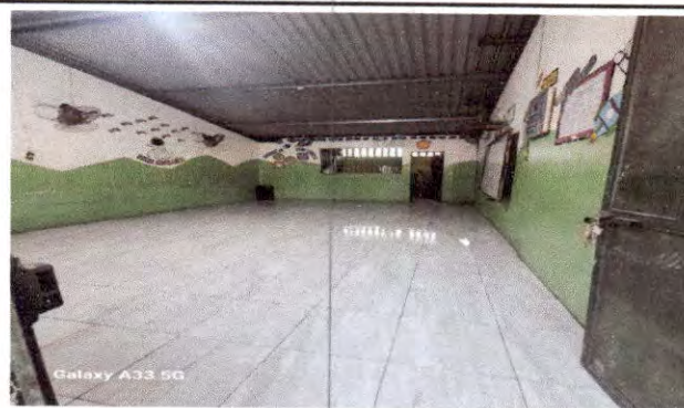
Foto 4: PISO: Sustitución de piso de cemento líquido por piso cerámico de 4 aulas y pasillo de módulos 1 y 2 de aulas.
