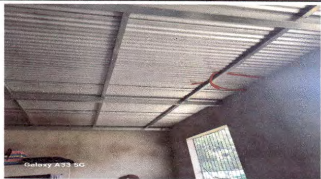
Foto 1: CUBIERTA DE LÁMINA: Sustitución de lámina acanalada por lámina troquelada y sustitución de la estructura de metal en cocina.
