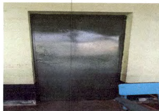
Foto 2: PUERTAS DE METAL: Mantenimiento a estructura (lijado, cambio de tubo, cepillado, sujeciones) y sustitución de chapa 13 puertas en módulos 1 y 2 de aulas
