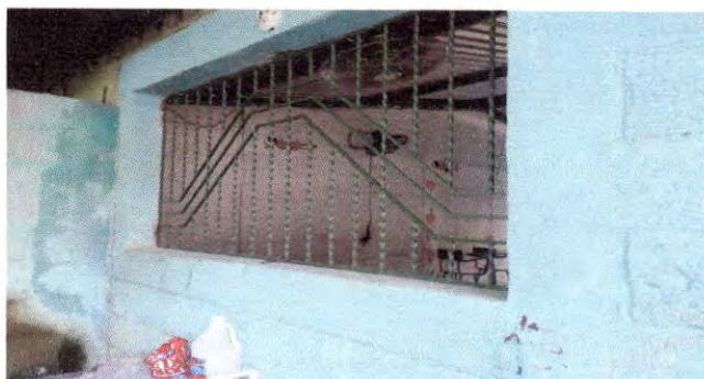
Foto 9: Ventanas: Sustitución de balcón de hierro en módulo 1 de aula.
