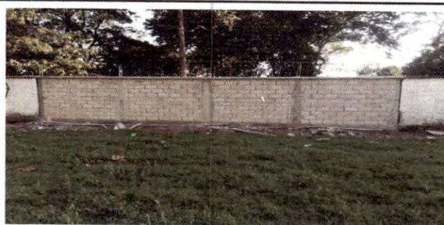
Foto 6: MUROS PERIMETRALES: Reparación de muro perimetral de block 43m2 en área del campo de futbol.
