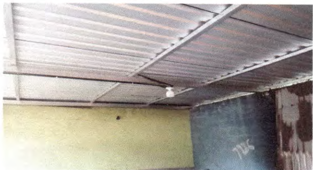
Foto 11: Mano de obra especializada (albañilería, herrería, electricidad) instalación unidades de luz en cocina y salón.
