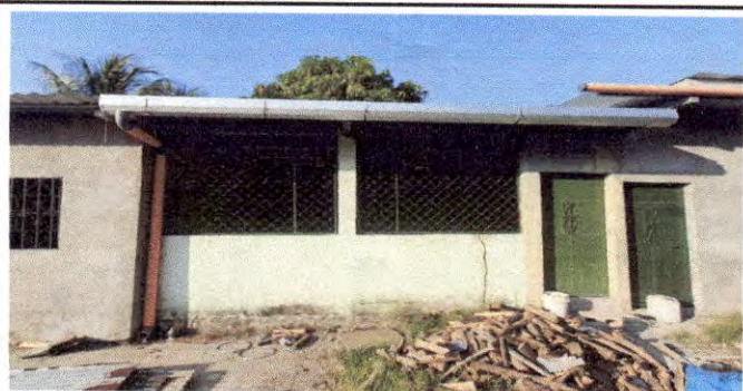
Foto 5: CANALES Y BAJADAS DE AGUA PLUVIALES: Sustitución de canal de aguas pluviales de 2 aulas de PVC 18ML, módulos de cocina y salones.
