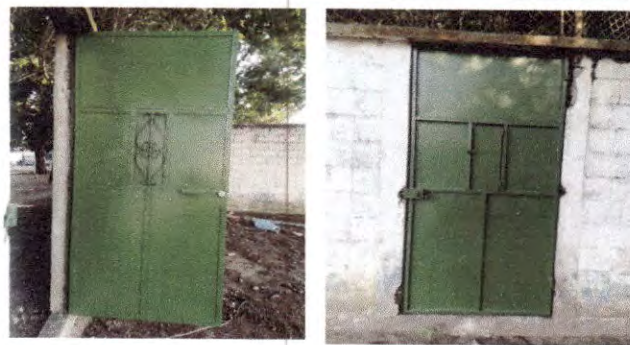
Foto 10: Puerta: Sustitución de puerta en área del campo de fútbol.
