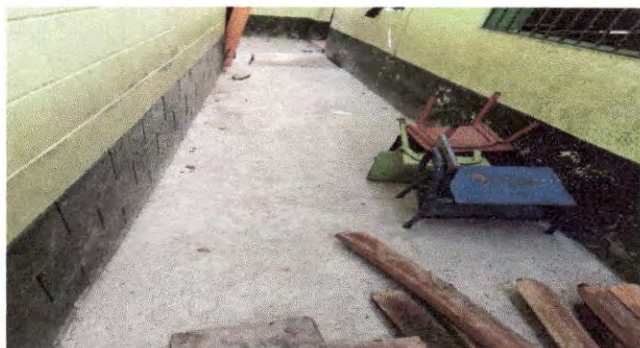
Foto 7: Losa de patio: Reparación de plancha de concreto de patio 15m2 en módulo 1 de aulas.
